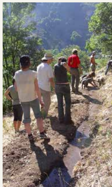
Avec Concordia, la remise en état d'un canal d'irrigation sur près de 800 m cheminant à flanc de montagne
