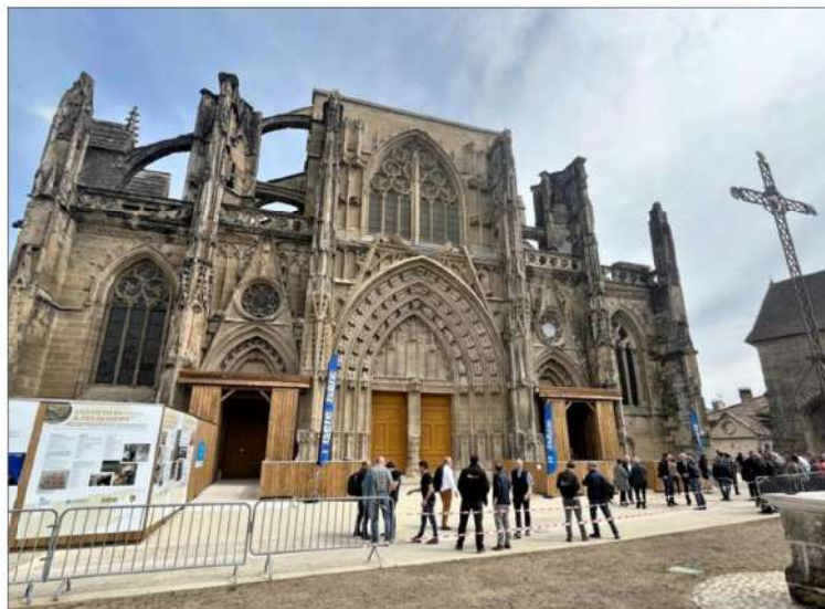
La façade de l'abbaye de Saint-Antoine-l'Abbaye a été en partie rénovée en 2023. La restauration complète est évaluée à plus de 5 millions d'euros. Et malgré les 500 000 € d'aide accordée par le Loto du patrimoine, les travaux ne vont pas reprendre avant 2025. Photo archives Le DL/Clément Berthet
