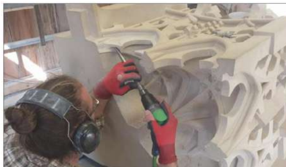
Manang et Glénat a participé à la première phase de restauration de la façade de Saint-Antoine-l'Abbaye. Une taille de pierres « d'une complexité incroyable », selon le président de l'entreprise Mathias Monier. Photo MNG
