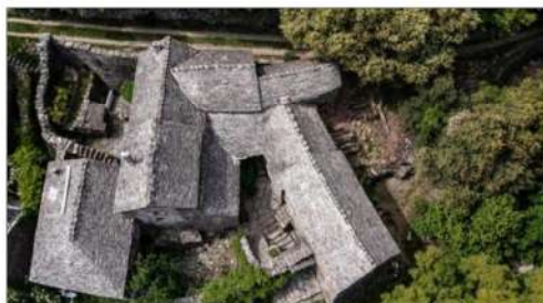
La toiture couvrant la partie habitation du mas fortifié doit se terminer en mai prochain. Celle de la grange est prévue pour 2024-2025. Photo DR
