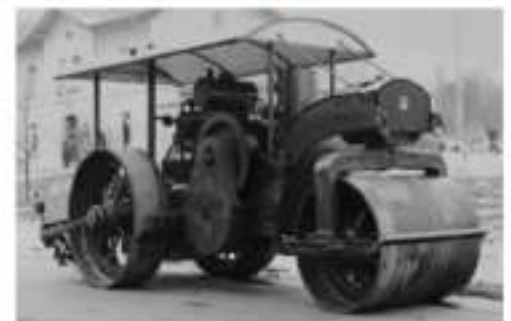
Rouleau compresseur pour le compactage du sol.
