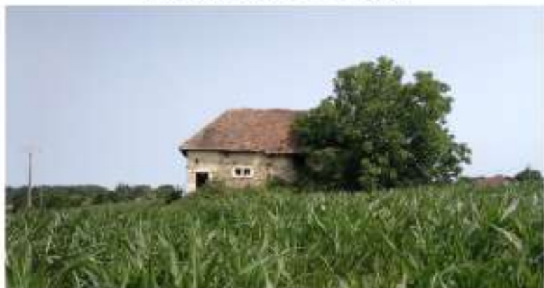
Ancien pavillon de chasse daté de 1560 sur un mur.
