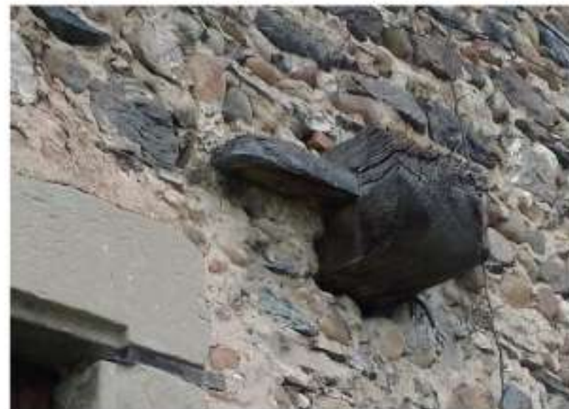
Clé de tirant en bois afin d'éviter l'écartement des murs
