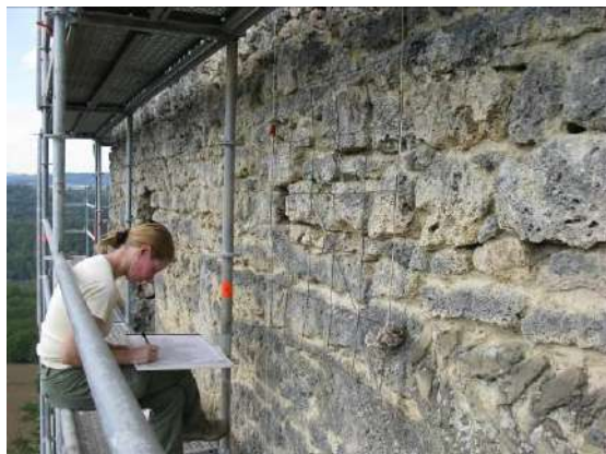
Relevé au cadre , château de Beauvoir-en-Royans © Service du patrimoine culturel, Département de l'Isère
