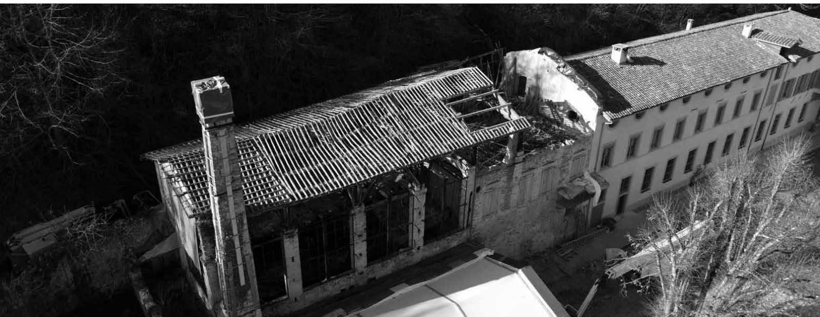
*Chantier de déconstruction de la charpente de la filature suite à son effondrement partiel*
