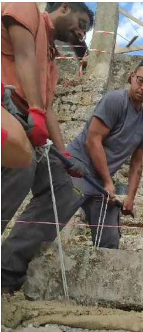
Sur la gauche, pose de gros cailloux à l'entrée de la base de l'appareillage est calculé. Sur la gauche, pose en vrac des restes de taille. Le dernier rang de pierres maçonnées l'on peut voir en dessous.
