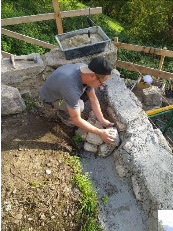
Sur la gauche, pose de gros cailloux à l'entrée de la base de l'appareillage est calculé. Sur la gauche, pose en vrac des restes de taille. Le dernier rang de pierres maçonnées l'on peut voir en dessous.
