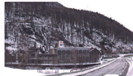
2 CENTRALE HYDROÉLECTRIQUE DE LIVET
